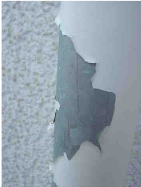
Bild I: Verzinktes Rohr mit versprödetem Kunstharzlack auf Alkydharzbasis
